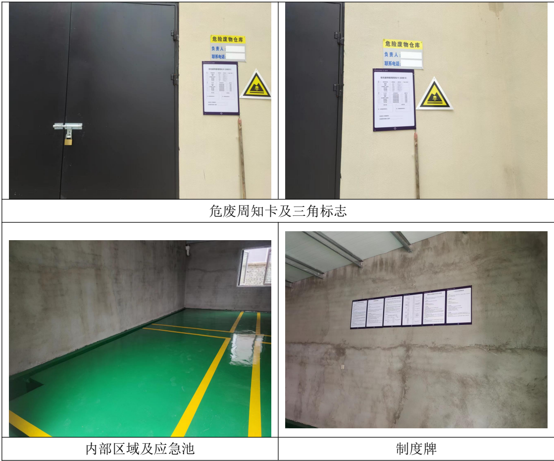
图 4.1-2 危废仓库现场照片
